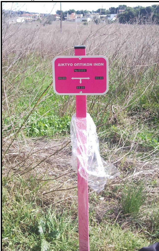
Ηοι, Πανελλαδικά Σήμανση δικτύου οπτικών ινών
