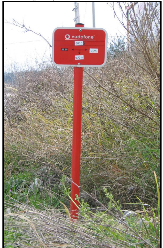
Vodafone, Πανελλαδικά Σήμανση δικτύου οπτικών ινών
